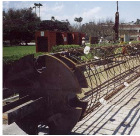
Singolo livello di un'insieme di O-cell pronto all'installazione.
