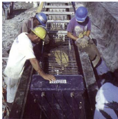
Installazione di una cella di Osterberg in un palo prefabbricato in calcestruzzo
