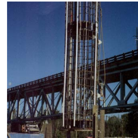
Complessivo a più livelli della O-cell
